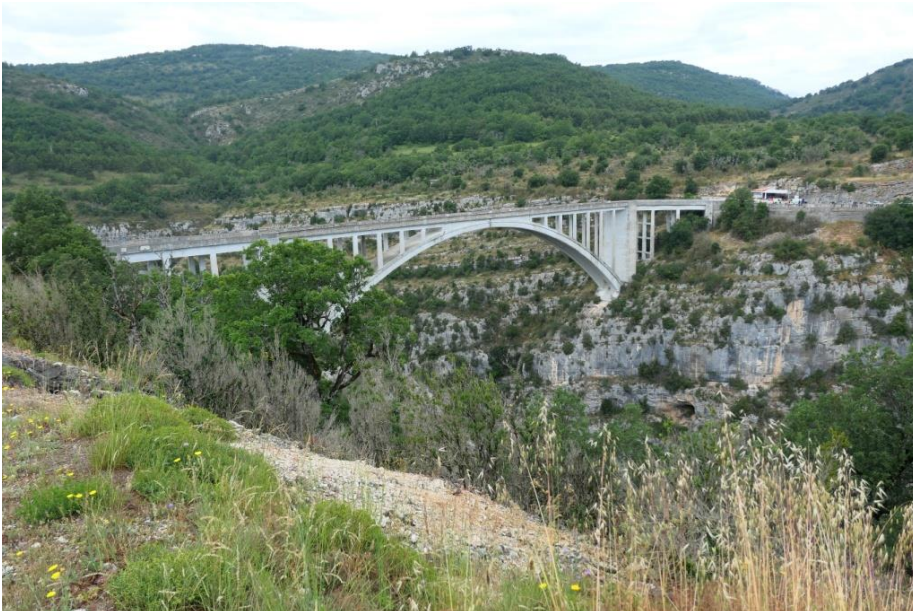
Die Brücke auf der wir vorher waren.
